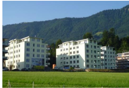
Überbauung Harmettlen, Goldau
