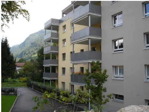
MFH Bachweg, Goldau
