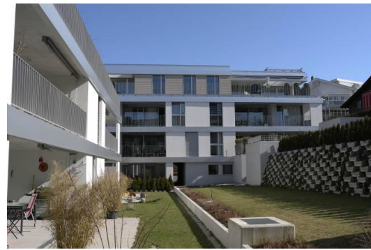
Überbauung Dorfmatte, Allenwinden
